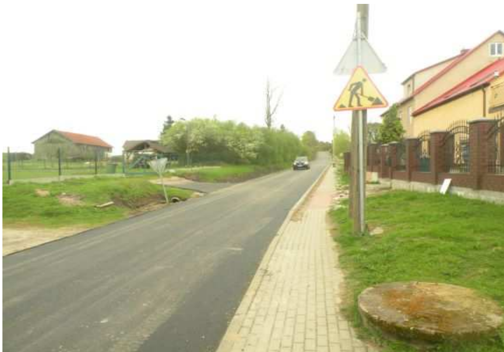
Przebudowa drogi powiatowej 1413N na odcinku Wolnica-Różyn
